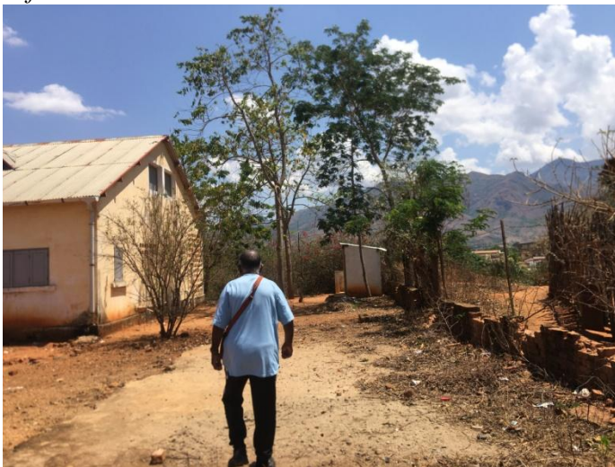
Muret avant réparation
