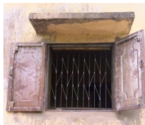
Pose de grilles de protection et de fenêtre en fer
