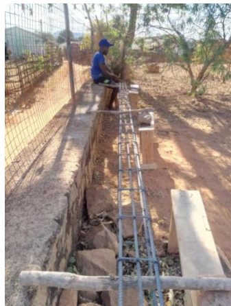
Préparation du béton armé
