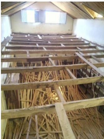
Démolition du plancher
