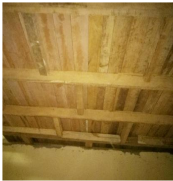
Le plancher vu de dessous
