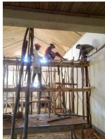
Coffrage pour le béton armé
