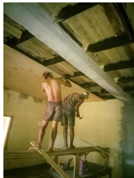
Finition : Pose des voliges
