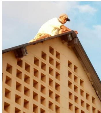
Réparation de la toiture
