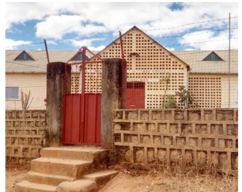
CCIC après réparation de la toiture
